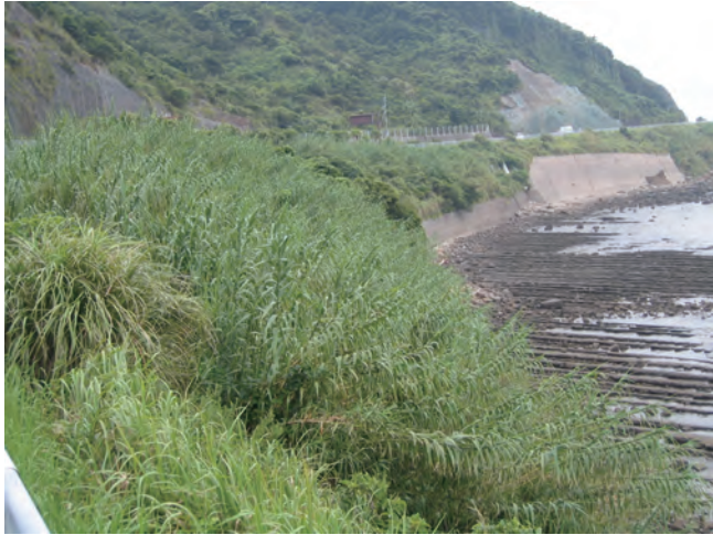
Photo 3. 日南市の海岸 (撮影:2006年8月30日)
