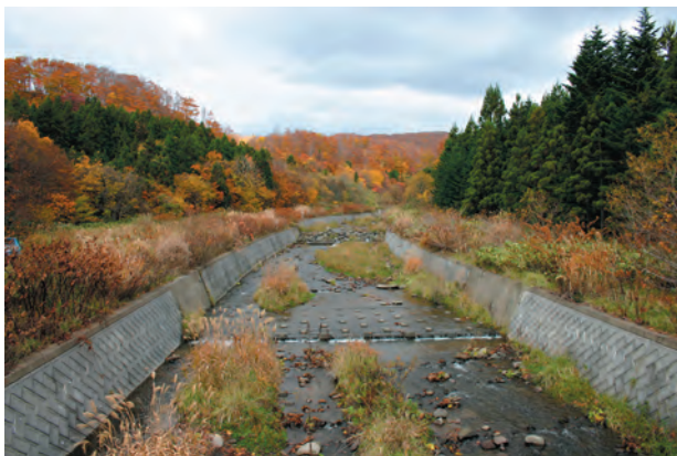
Photo 5. 青苗川中流域における河川改修の状況.
